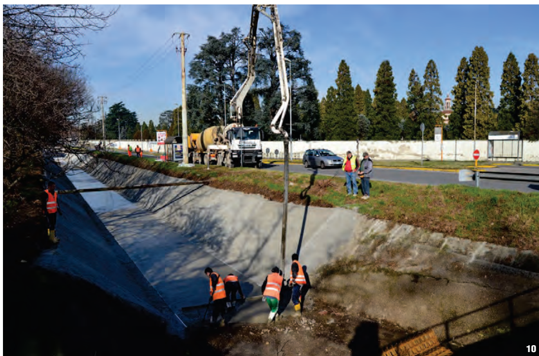
10. Una fase esecutiva: in cantiere hanno operato betoniere, pompe, addetti specializzati e operatori preposti al controllo di qualità
